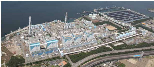
愛知県の碧南火力発電所は石炭火力としては国内最大、世界でも最大級の出力410万kWを誇る。同発電所4号機(出力100万kW)で、燃料の20%をアンモニアに転換する世界初の大規模実証試験が2024年3月より開始予定
