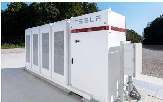
白井DCCに導入された、テスラ社製の大容量リチウムイオン蓄電池「Powerpack」。日中の太陽光による自家発電や夜間の安い電力の買い入れなどと組み合わせ、電力の安定供給と消費電力の削減を推進する
