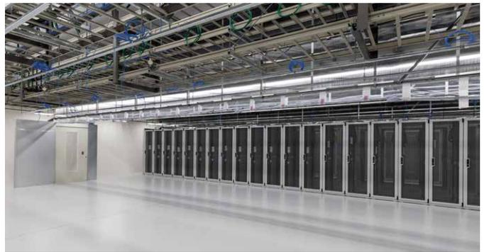
左:白井DCC2期棟の外観。2期棟は床面積が約8,000㎡で、1期棟の1.6倍となる約1,100台のラックを収容可能。右:サーバー室の空調は、冷たい外気を取り入れる外気冷却方式。AIを使って空調を自動制御し、冷却コイルが設置された壁面の送風口を通すことで、室内への給気温度を常に24℃前後に保つ。床から冷風を送る方式に比べ、動力を3分の1に削減した
