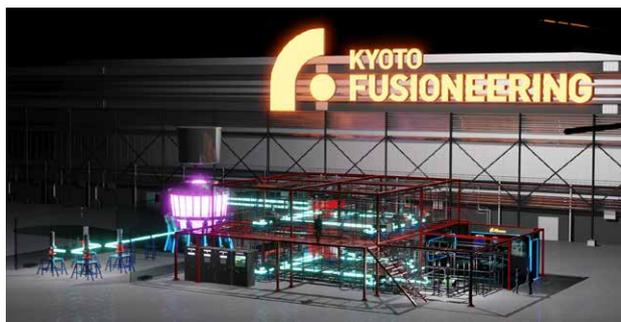
京都フュージョニアリングが建設を進める、フュージョンエネルギーによる発電のための世界初の試験プラント「UNITY(Unique Integrated Testing Facility:独自統合試験施設)」。放射性物質を用いず核融合炉内と同等の高温・強磁場の環境を構築し、一連の発電システムが実証可能となる
