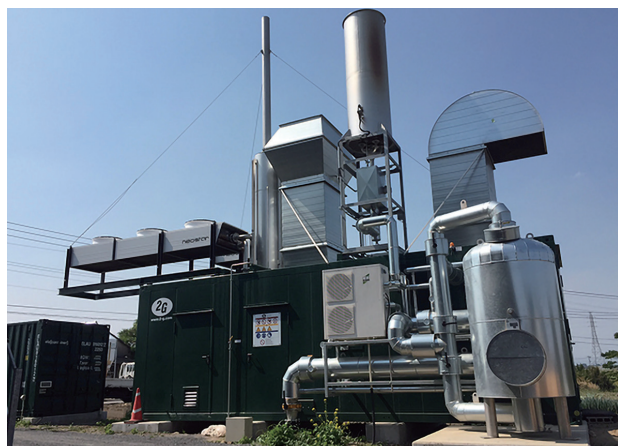
マヨネーズの残渣と豚の糞尿を掛け合わせてバイオガス発電に利用するための設備。現在、茨城県・五霞工場をはじめ、国内5カ所に設置されている。これまで累計670メガワットを発電。これは、渋谷の本社オフィス施設1年分の電力消費量に値する
