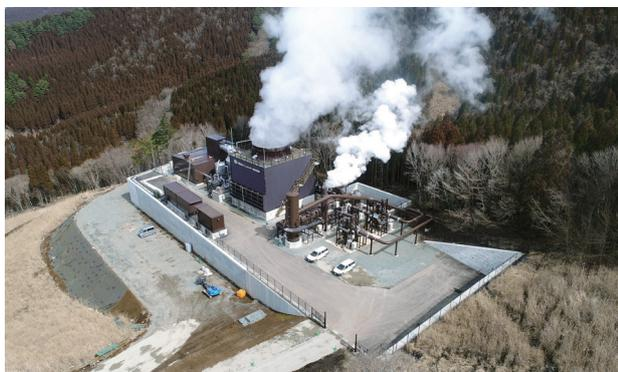
約100億円をかけ、熊本県小国町の涌蓋山のふもとに完成した「小国町おこしエネルギー地熱発電所」。最大出力4,990キロワットで8,000世帯ほどが1年間に使う電力量をまかなえる。また熱水を使った野菜のハウス栽培や、エビ・甲殻類、ヤマトシジミなどの養殖事業も試みている
