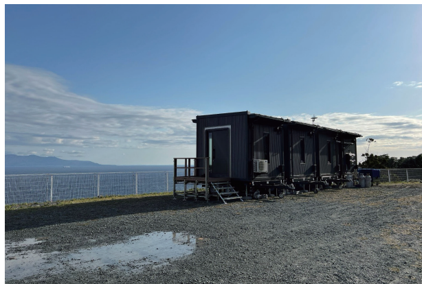
利島村での実証実験「利島プロジェクト」で設置された、水再生機能を備えるトレーラーハウス。排水の98%を再利用できる
