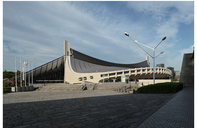
国立代々木競技場第一体育館の屋根。吊り橋のように2本の支柱を立て、その間にワイヤーで屋根を吊る「吊り屋根構造」は、画期的なデザイン・技術が世界的に注目された
