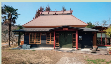
17年以上空き家だった築100年の古民家「編蝠亭」を、地元木材を用いて再生し、本社施設に。トイレは循環型のコンポスト式で、照明は全てLEDを使用するなど持続可能なオフィス環境も実現
