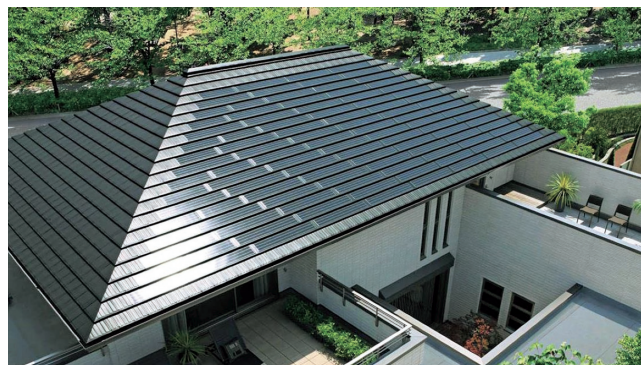
積水ハウスオリジナルの瓦型太陽電池パネル。発電装置と屋根素材の機能を兼ね備え、デザイン的にも優れていることから、2009年度グッドデザイン賞を受賞した
